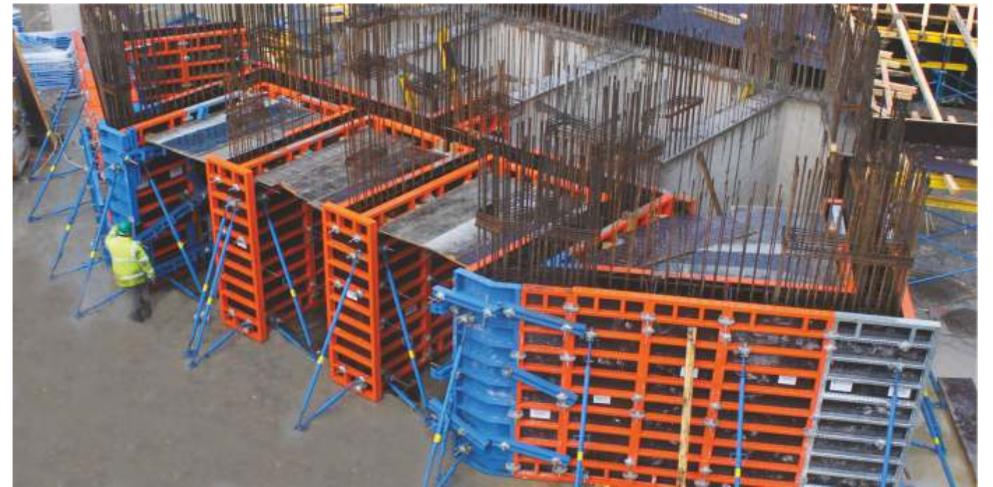
Rapido Dış Köşe kullanarak Using Rapido External Corner Panel
