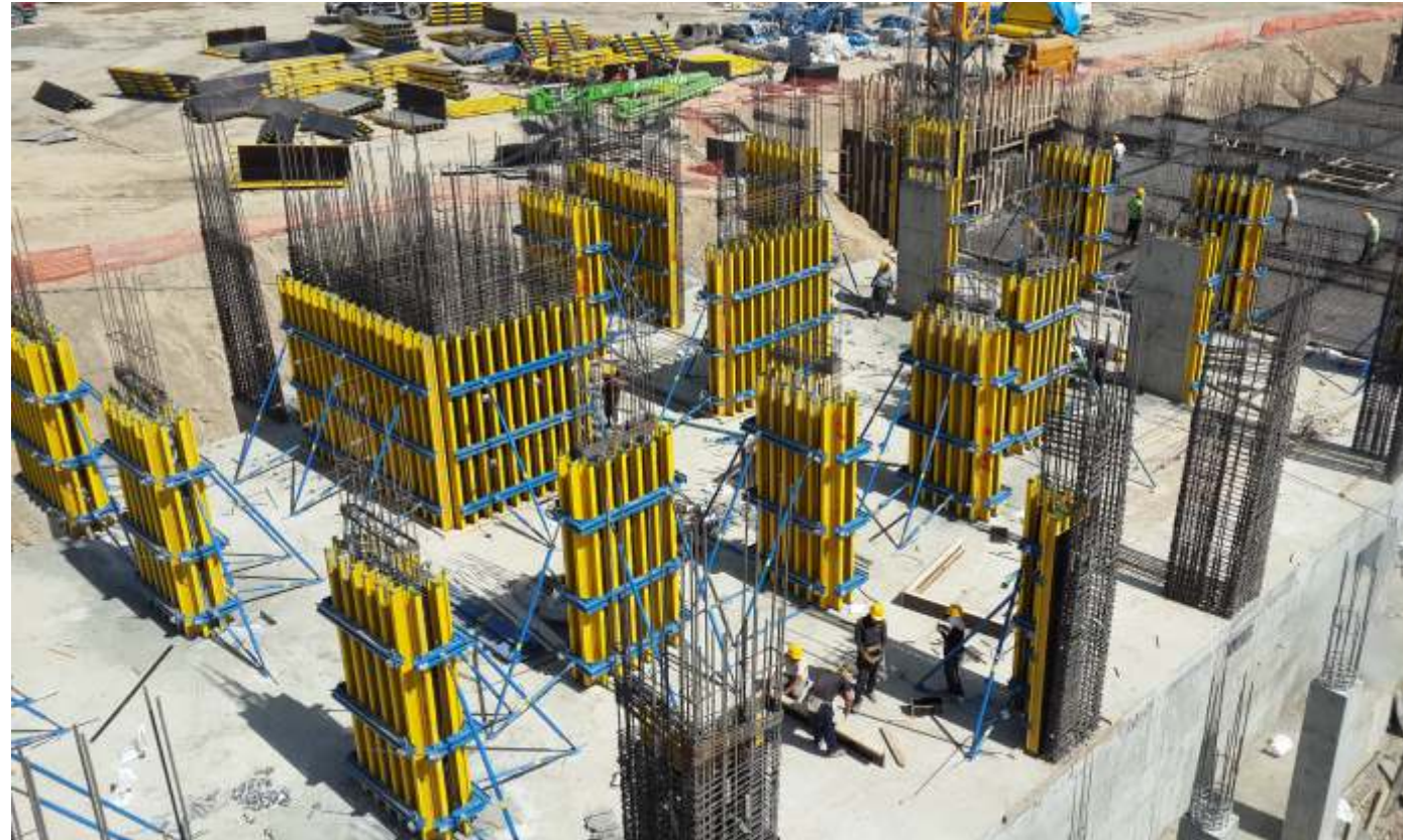
Çekirdek perde kalıplarının kolay bir şekilde sökebilmek için paneller arasında adaptör montajlanır. Beam clamp is placed between panels to enable removing of wall formworks inside core wall.
